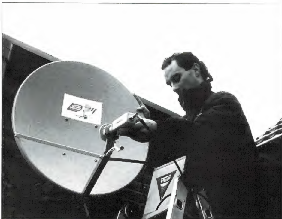
Het uitrichten met een goede S-meter is belangrijk voor een goed signaal, ook bij offset schotels.
